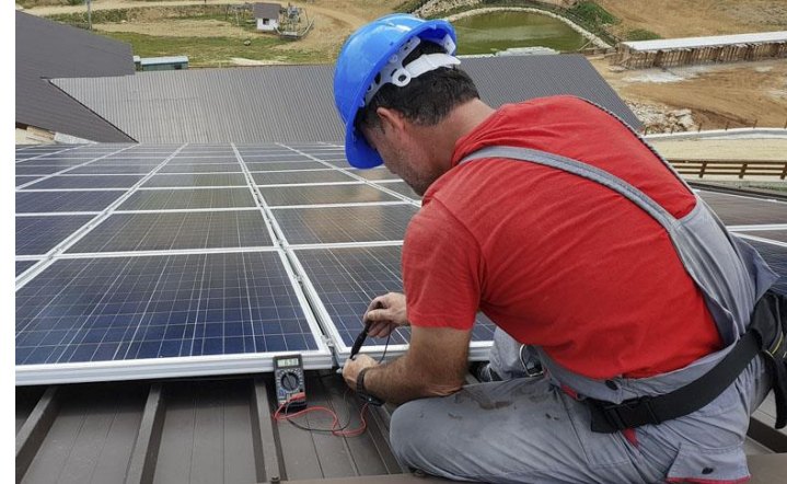
INSTALADOR DE MÓDULOS
